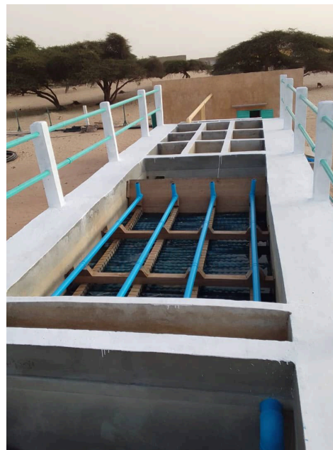
Les ouvrages de traitement
