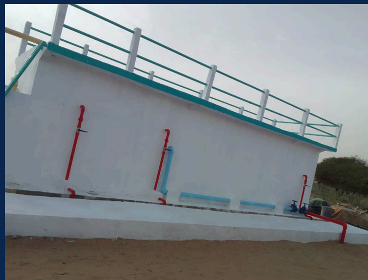
La station de traitement
