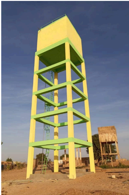
Le château d'eau
