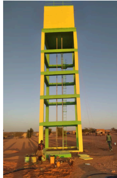
Le réservoir surélevé
