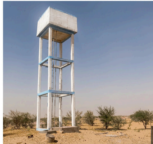
Château d'eau à Koubenni
