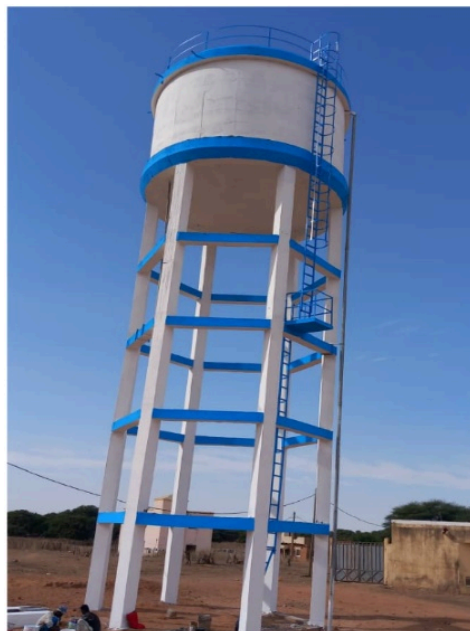
Le château d'eau cylindrique
