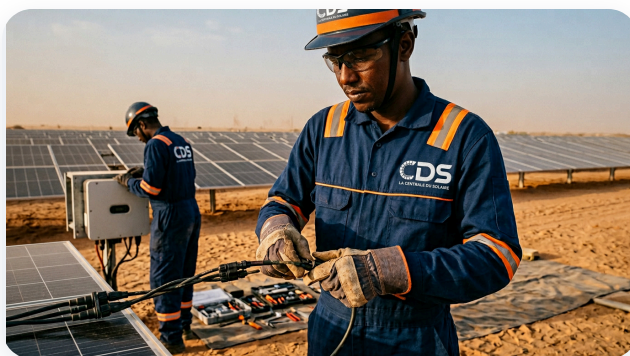
Intervention sur site
